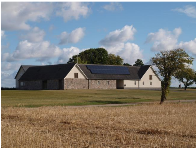
Eksempel på godt arkitektonisk tilpasset solcelleanlæg på
