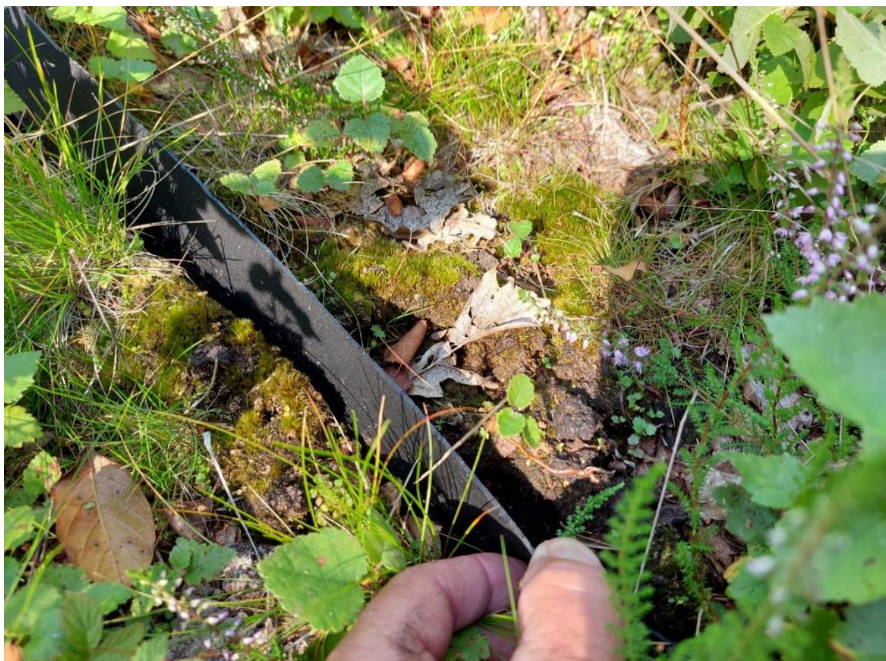
Den kraftige HDPE-membran af gummi, som skal forhindre sommerens nedbør i at løbe ud af den centrale del af Sandlyng. Bemærk de mange spirende birke, der hurtigt kan give den oprindelige lyngvegetation hård konkurrence om det livgivende lys. Foto: AF 11. august 2022.
